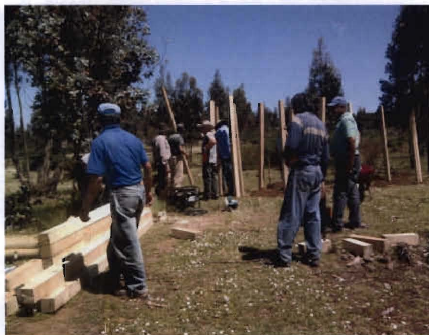
Construcción mangas manejo bovino
