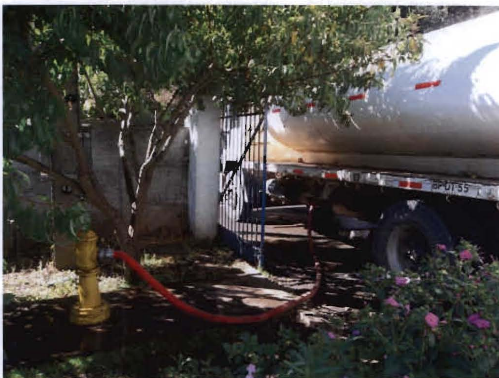
Abastecimiento desde planta de aguas araucania de galvarino
