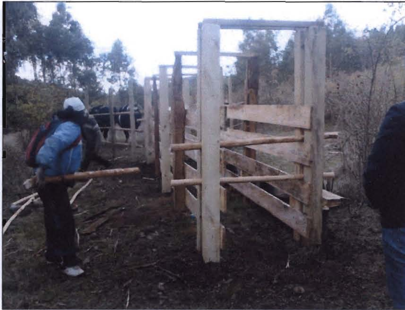
Manga reparada en el Sector de Pangueco
